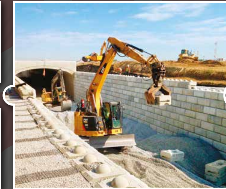
OUVRAGE D'ART, VOIRIES ET RÉSEAUX ROUTIERS
