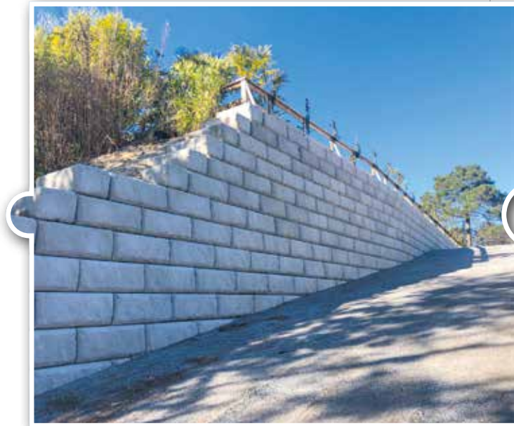
SOUTÈNEMENT DE TERRAIN
