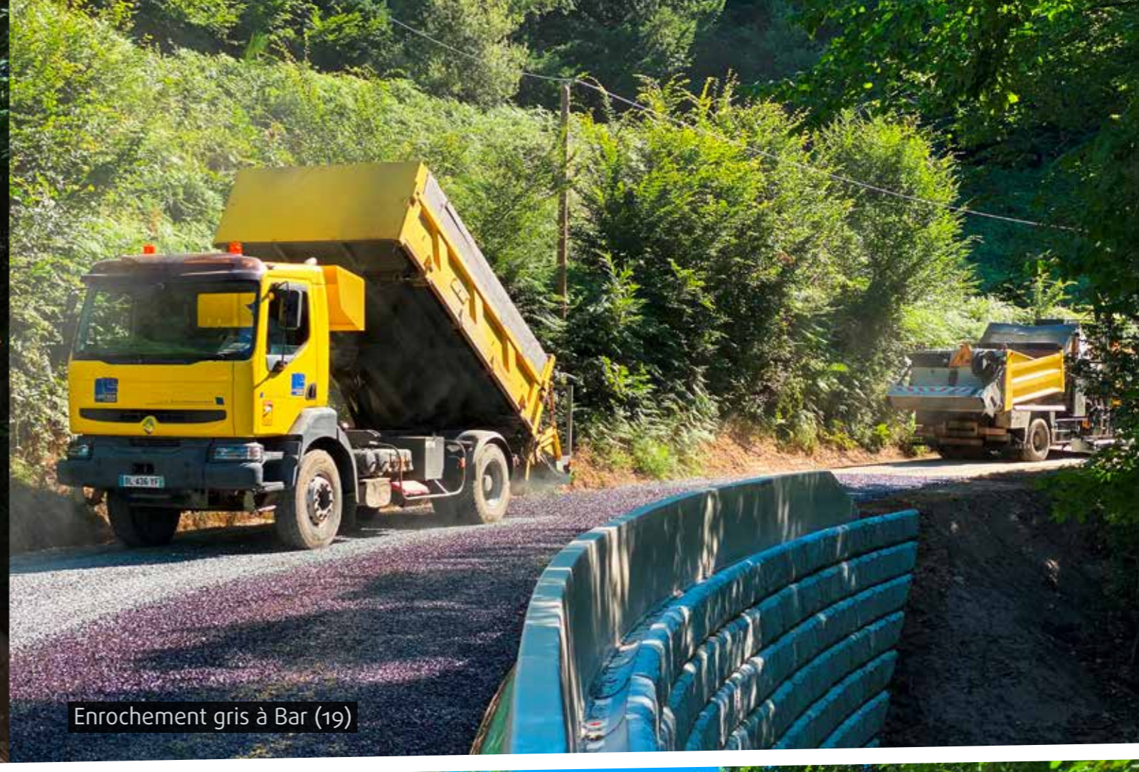
Enrochement gris à Bar (19)
