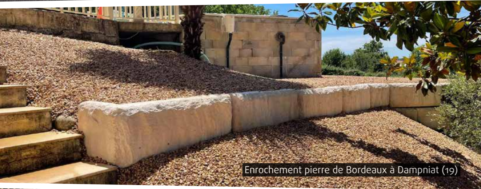
Enrochement pierre de Bordeaux à Dampniat (19)
