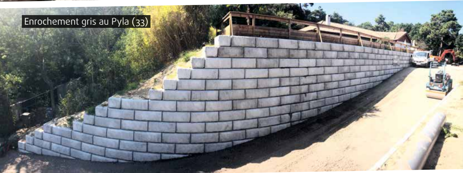
Enrochement gris au Pyla (33)
